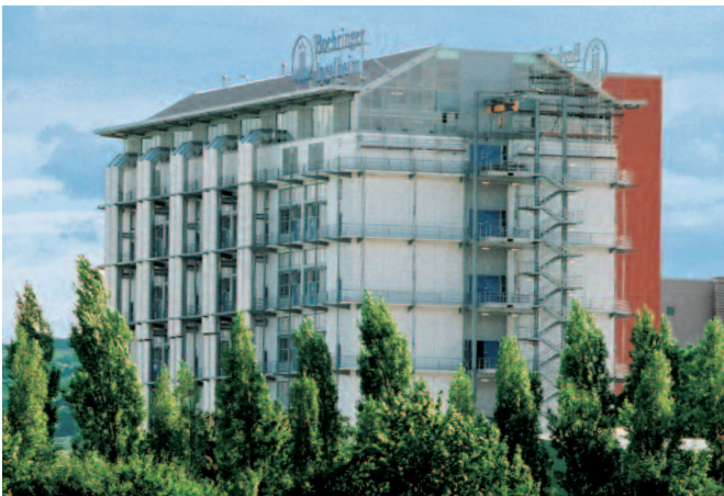
Der 50 Meter hohe Pharma-Wirkstoffbetrieb ist als Mehrzweckanlage zur Synthese pharmazeutischer Wirkstoffe konzipiert. Er wurde 2003 in Ingelheim errichtet.
